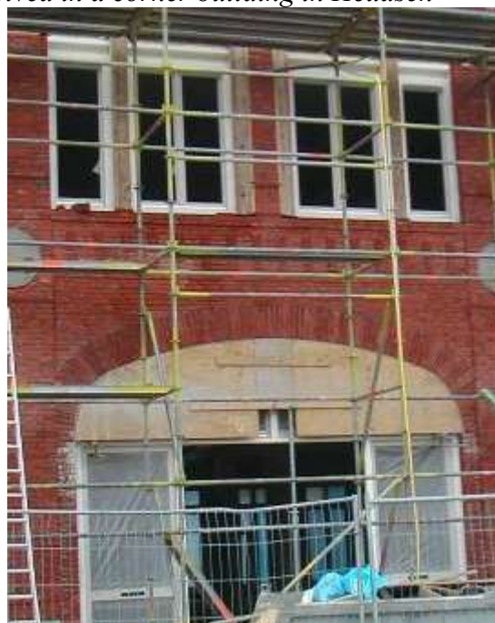
Quello che avrebbe voluto essere un arco ellittico in un edificio di Brandevoort: essendo sbagliata in partenza la sagoma della centina, anche la disposizione dei mattoni risulta assurda e spigolosa – What they intended to be an elliptical arc in a building Brandevoort: the shape of the rib is incorrect, with even the arrangement of the bricks absurd and angular
