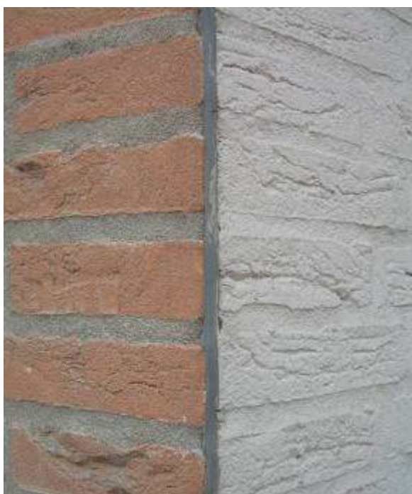
Discutibile soluzione d'angolo in un edificio di Brandevoort – Questionable corner solution in a building in Brandevoort
