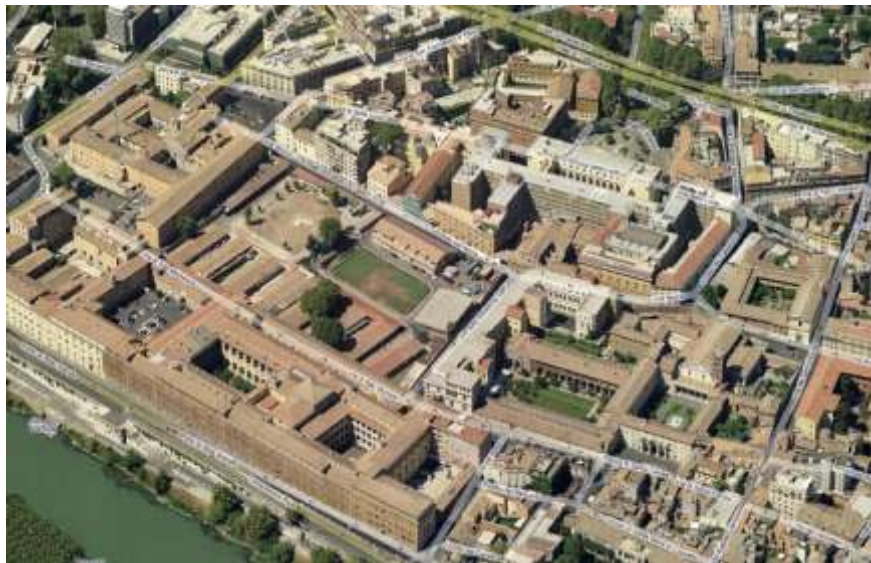
Vista aerea del sito – Aerial view of the site
